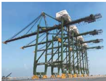
Indonesia Tanjung Priok Port 向け岸壁コンテナクレーン
