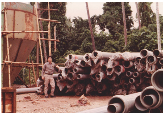
塩ビ管が山積みされたジャワ中部の簡易水道工事現場で
